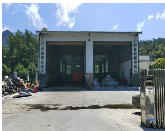
小村乡垃圾中转站
