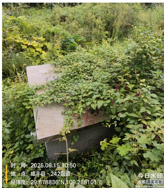
冲洗废水及渗滤液收集沟
